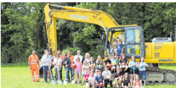
Die Kinder der 3./4. Klasse des Sulger Schulhauses Auholz wohnen dem Spatenstich bei.
