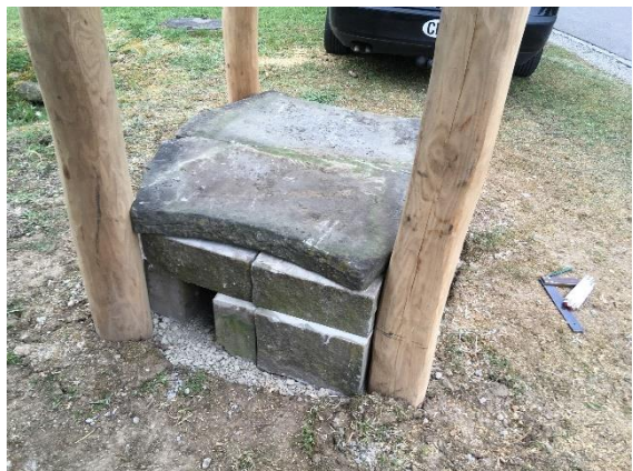
Eingang für den Igel Hohlraum freigelassen, mit Laub und Holzwolle befüllt.
