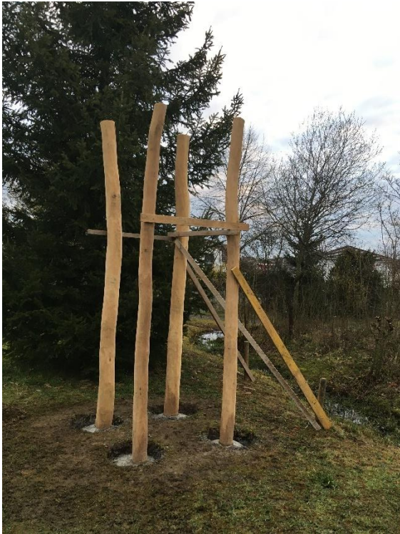
Pfähle einbetoniert
